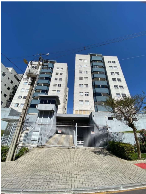
Fachada do Condomínio pela Rua Elvira Annabaletto
