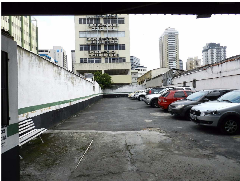
Foto 4- Vista atual da fachada do Lote 8, prédio nº 116 da Rua Padre Damaso, Matrícula nº 18.159.
