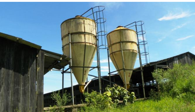
17. Item 69 - Silo de fibra de vidro
