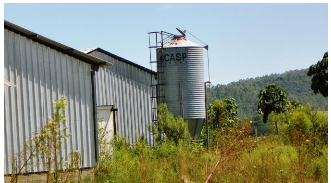
18. Item 66 - Silo de aço galvanizado
